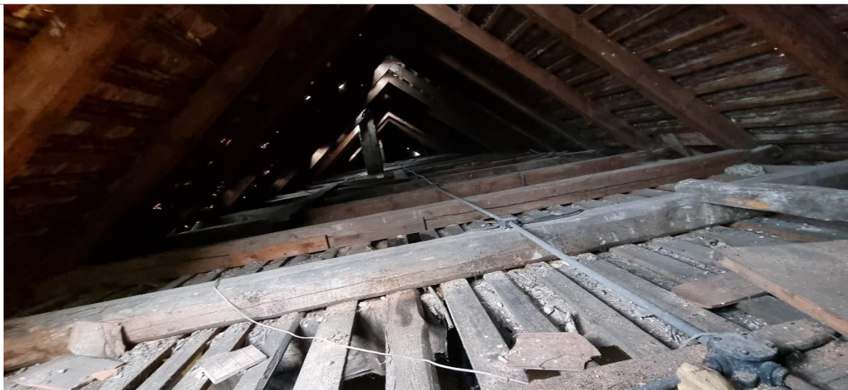
Rysunek 8 Strop płatwiowo jętkowy
