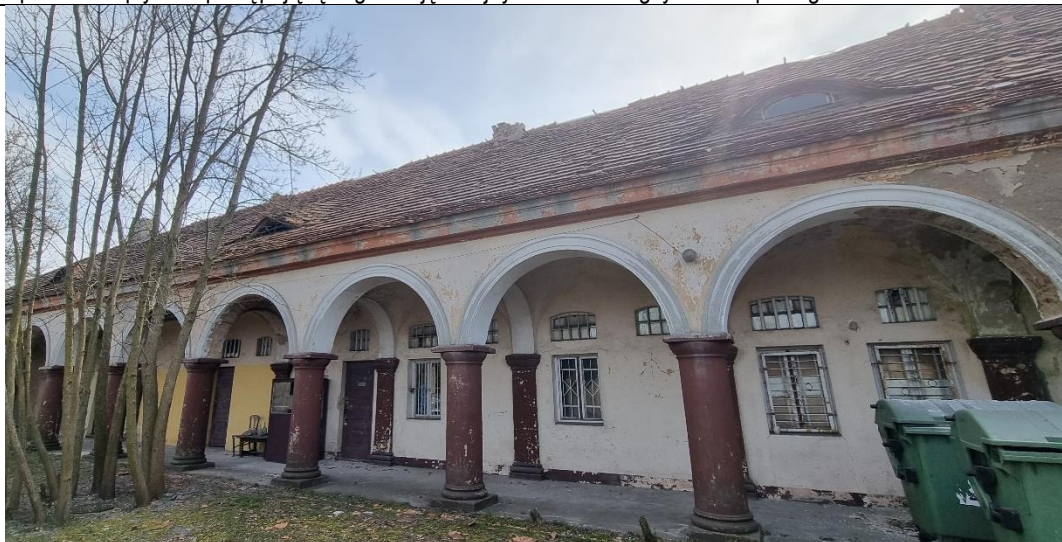
Rysunek 5 Brak orynnowania, płotków przeciwśnieżnych, ław kominiarskich
