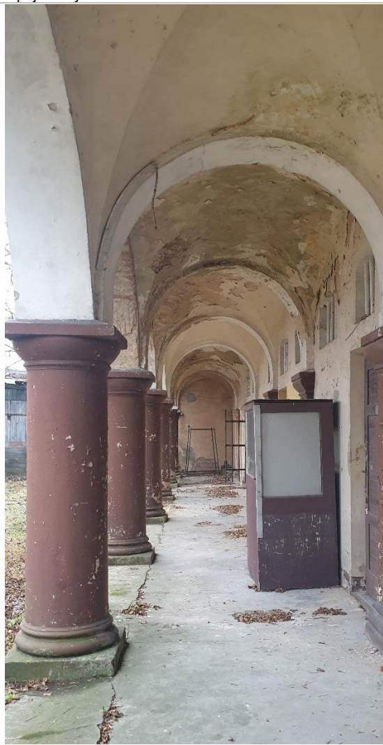
Rysunek 17 Odspojenie tynku
