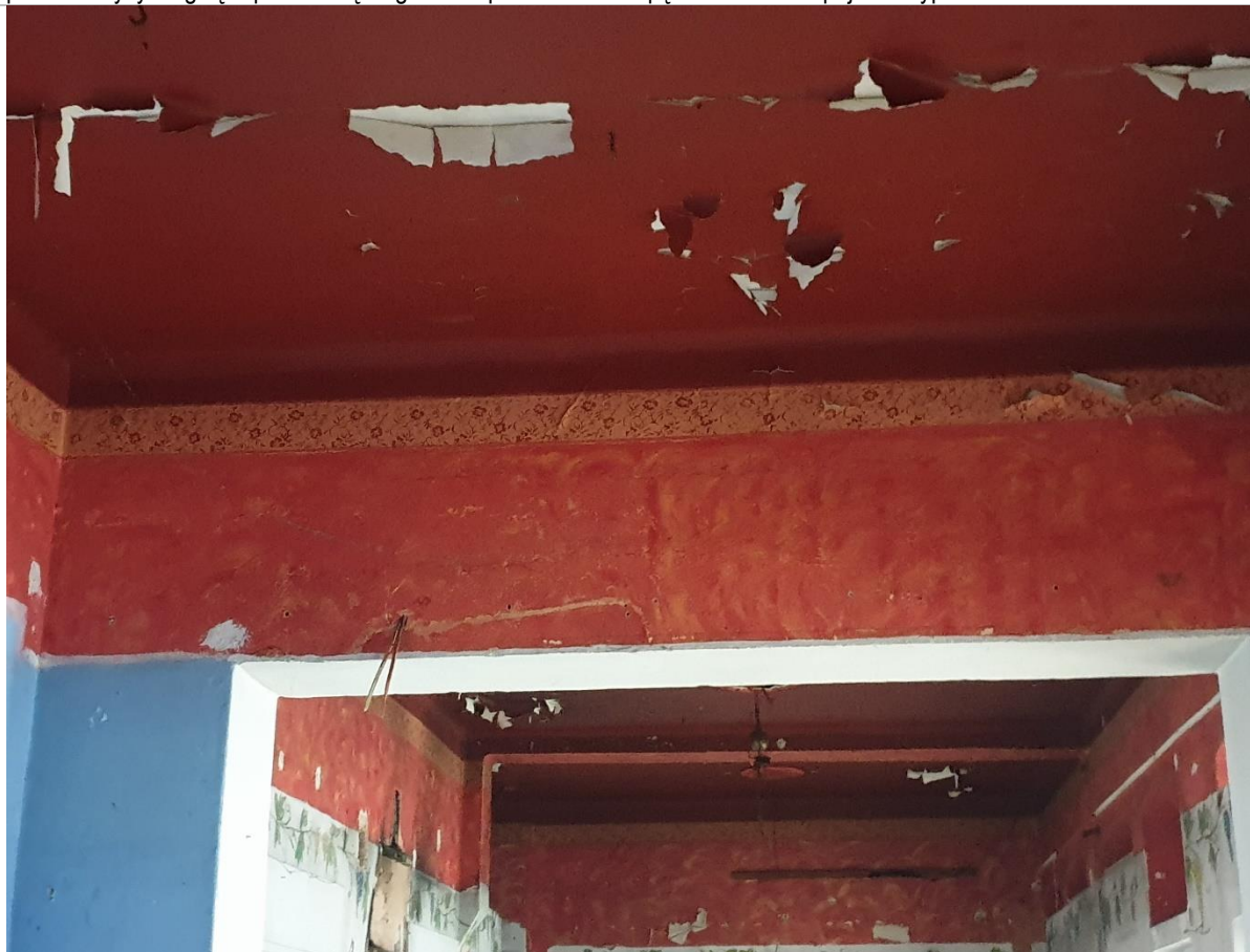
Rysunek 18 Odspojenie wypraw malarskich
