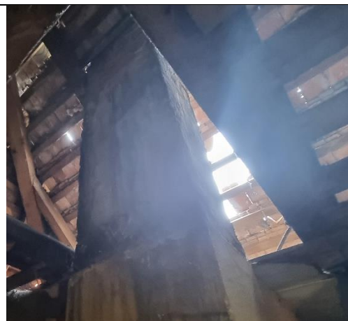
Rysunek 4 Liczne prześwity w poszyciu dachu
