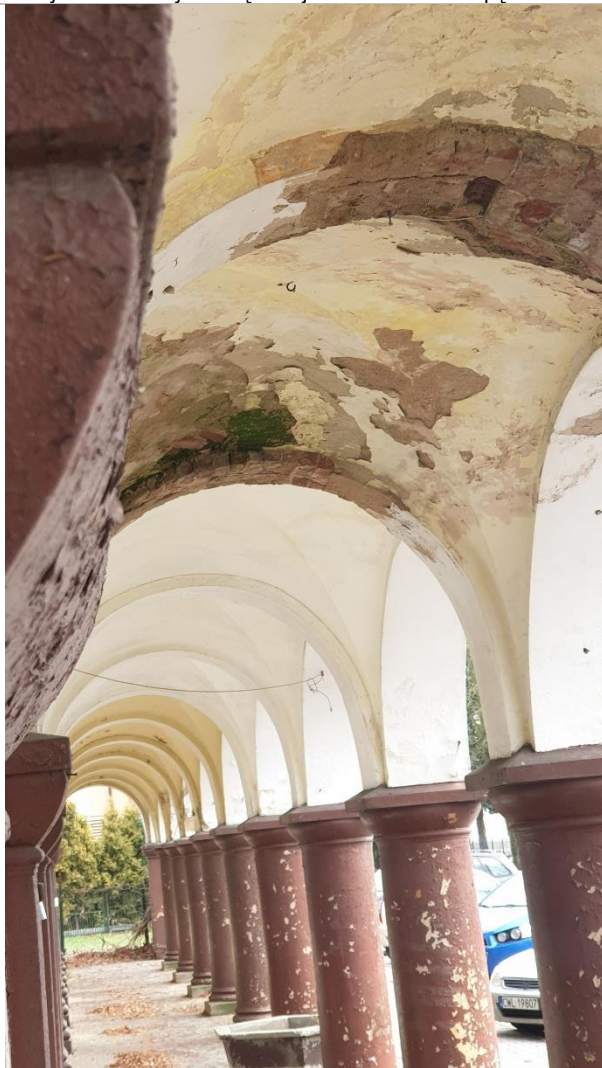
Rysunek 16 Odspojenie tynku
