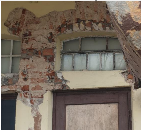
Rysunek 13 Odspojenie tynku, próba naprawy muru
