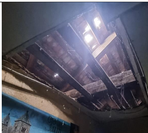
Rysunek 3 Liczne prześwity w poszyciu dachu
