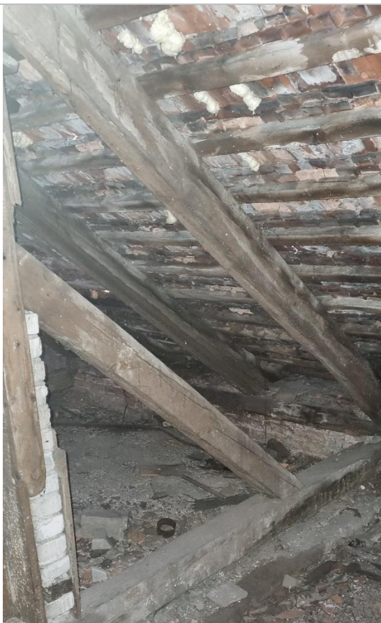
Rysunek 9 Część wieszarowa konstrukcji
