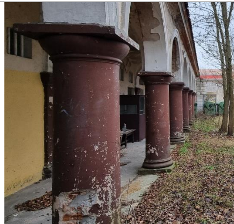
Rysunek 14 Rysa pionowa, odspojenie tynku łącznie z częścią muru
